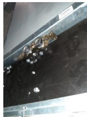
Serrure de porte palière du niveau principal
