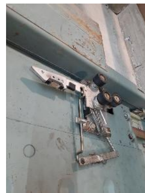
Serrure de porte palière du niveau principal
