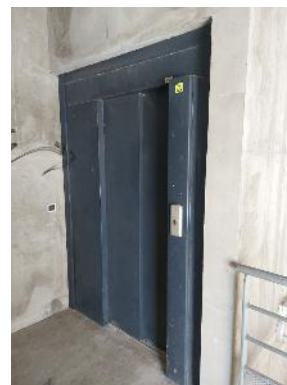
Baie palière avec armoire de commande
