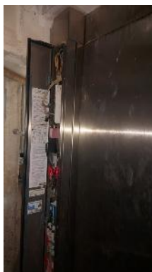
Dispositif de manoeuvre de secours au palier
