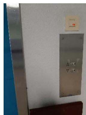
Commande palière du niveau principal
