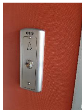
Commande palière du niveau principal
