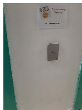
Commande palière du niveau principal
