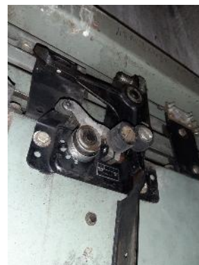
Serrure de porte palière du niveau principal
