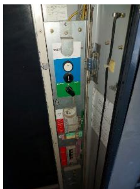
Dispositif de manoeuvre de secours au palier
