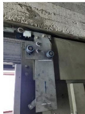
Serrure de porte palière du niveau principal
