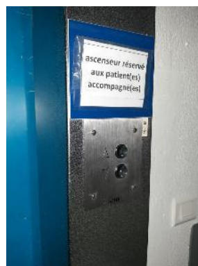
Commande palière du niveau principal
