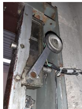
Serrure de porte palière du niveau principal
