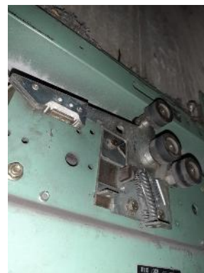
Serrure de porte palière du niveau principal
