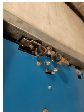
Serrure de porte palière du niveau principal
