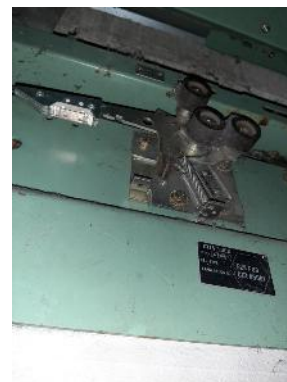
Serrure de porte palière du niveau principal
