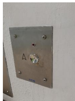
Commande palière du niveau principal
