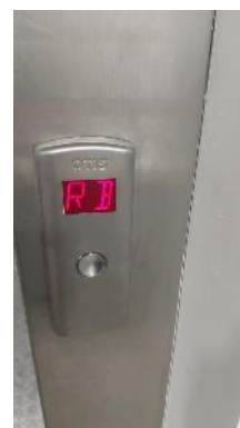
Commande palière du niveau principal
