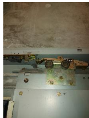
Serrure de porte palière du niveau principal
