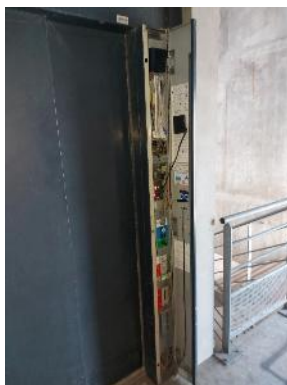
Trappe de commande au palier
